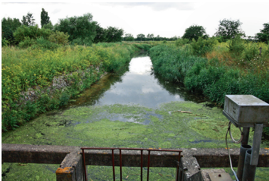
Den centrale pumpekanal, der leder frem til pumpestationen, er fyldt med grøngrøde, der vidner om et særdeles næringsberiget vandmiljø i Fjordmarken. Odense Fjord modtager et betydeligt tilskud af næringsstoffer fra denne kanal.
