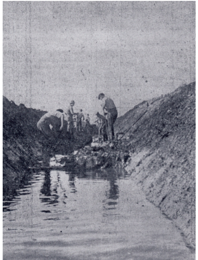
Opgravning af pumpekanalen.
