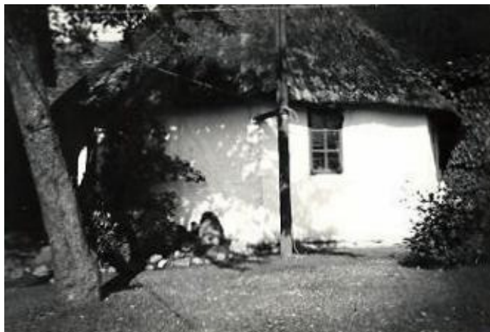
Hestegangen med vinduer isat hvor der før kun var luger. Foto privat 1943
