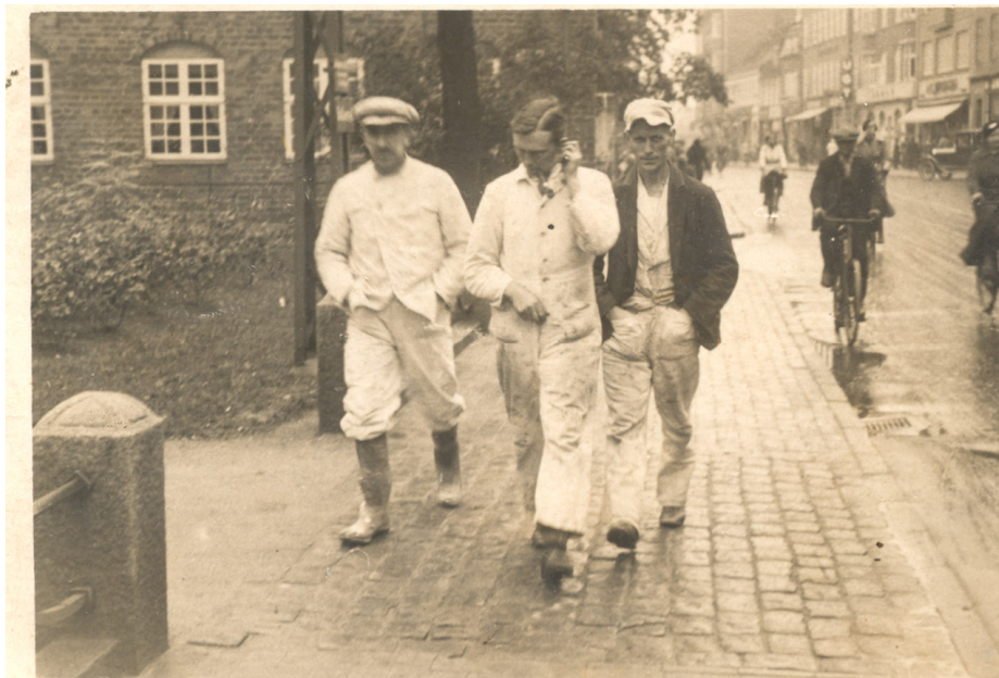
---og her Otto Knudsen til højre på vej til tømrerarbejdet på en byggeplads i Odense
